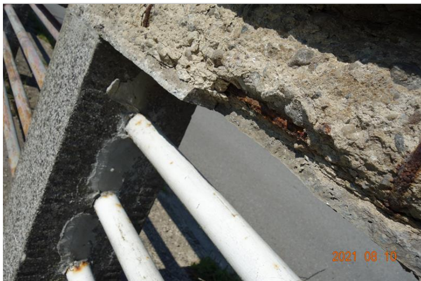
korozí madla zábradlí
