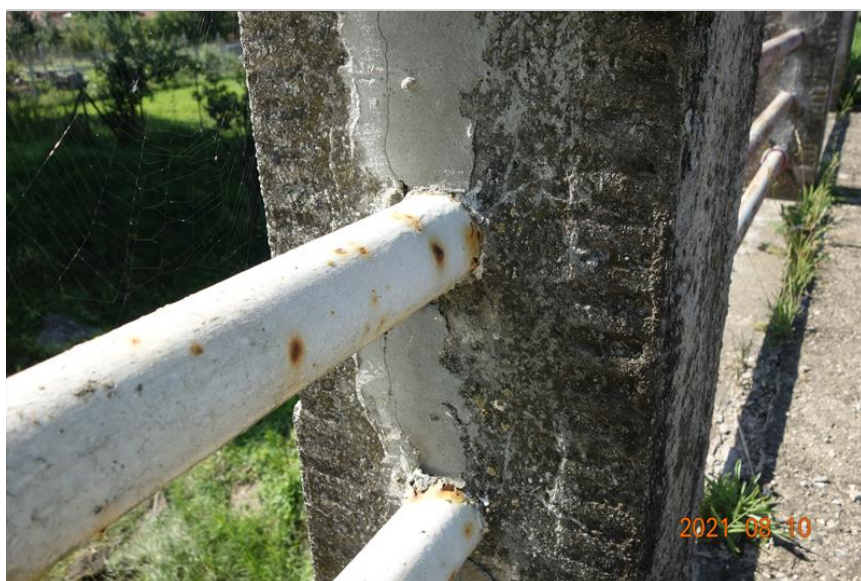
vysprávky sloupků zábradlí
